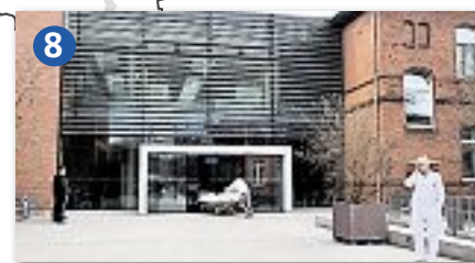
Klinikum Nordstadt: 24 051 stationäre Fälle, 52 000 ambulante Fälle, 515 Betten
